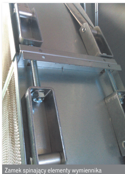
Montaż central w wentylatorni
